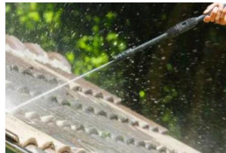
Mechanische Reinigung von Dachziegeln (© OST)
