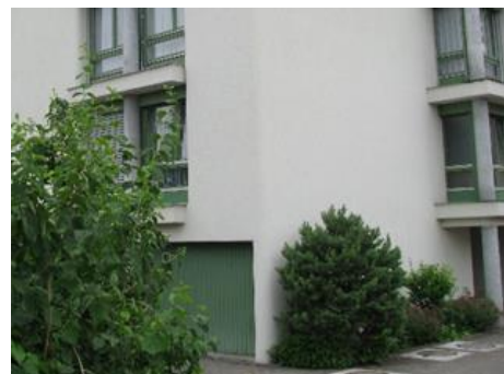
Bäume und Büsche an der Fassade (© OST)
