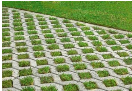
Rasengittersteine als Parkplatzfläche (© KWB)
