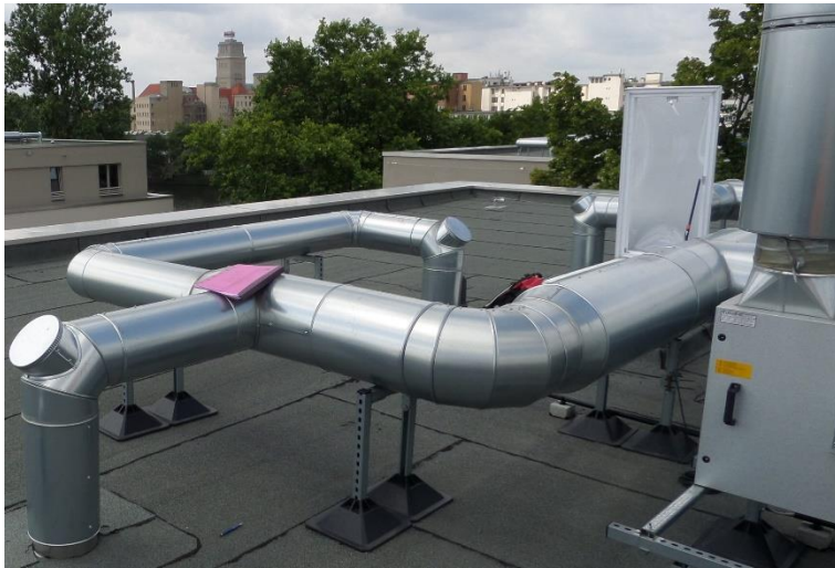
Abbildung 54: Dachaufbauten aus verzinkten Rohren in Testgebiet A
