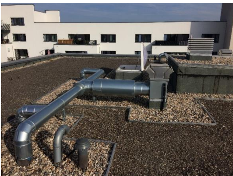
Abbildung 56: Dachaufbauten aus verzinkten Rohren in Testgebiet B
