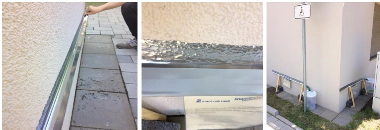
Abbildung 7: Installation der Fassadenrinnen im Testgebiet A
