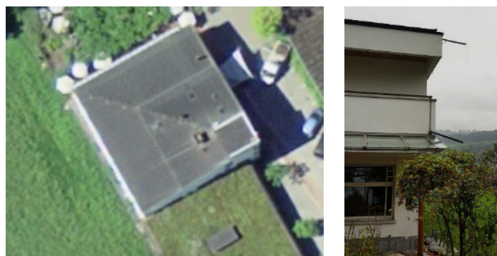
Abbildung 8: Beprobtes Kupferdach in der Gemeinde Pfäffikon SZ. Links: Dachfläche (Quelle: map.geo.admin.ch), rechts: Dachentwässerung auf angrenzende Wiese.
